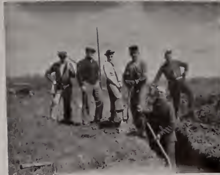
„Wir bauen auf!“ Freiwilliger Arbeitsdienst des O.D. der Ortsgruppe Cleveland bei den ersten Arbeiten zur Errichtung eines Sommerheimes. Auch die Frauen wollen nicht missig sein bei der Errichtung eines deutschen Gemeinschaftsheimes.
